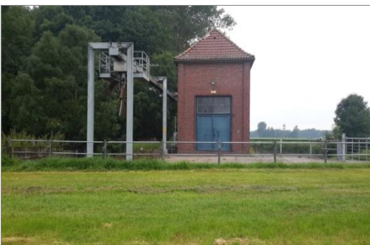
Schöpfwerk Jade Süd
